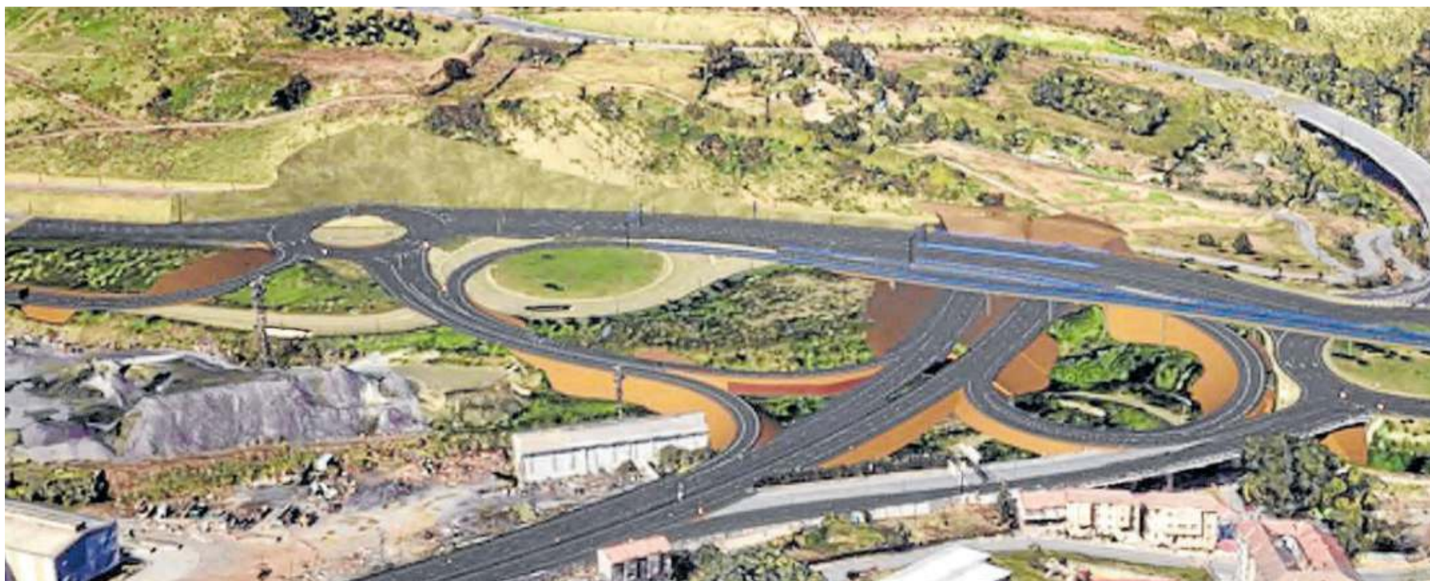
Los accesos al subfluvial en la zona de Sestao conectarán directamente con la autovía de Ugaldebieta para conectarse también con la Variante Sur Metropolitana. Foto: D. F. B.
