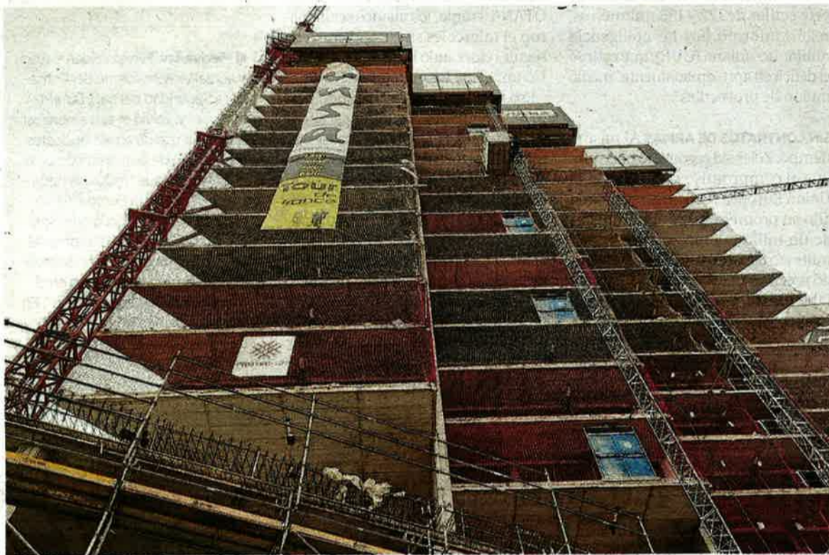
Imagen de un edificio en construcción. Foto: E.P.
