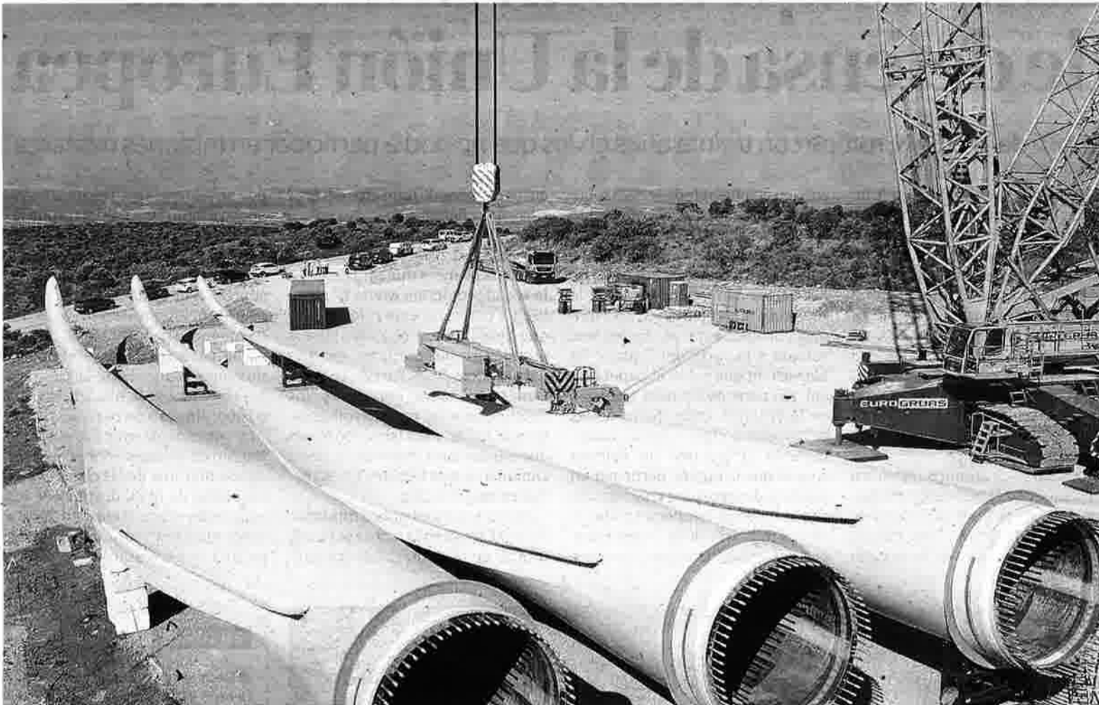
Unas palas desmontadas, en un parque eólico. Foto: cedida
